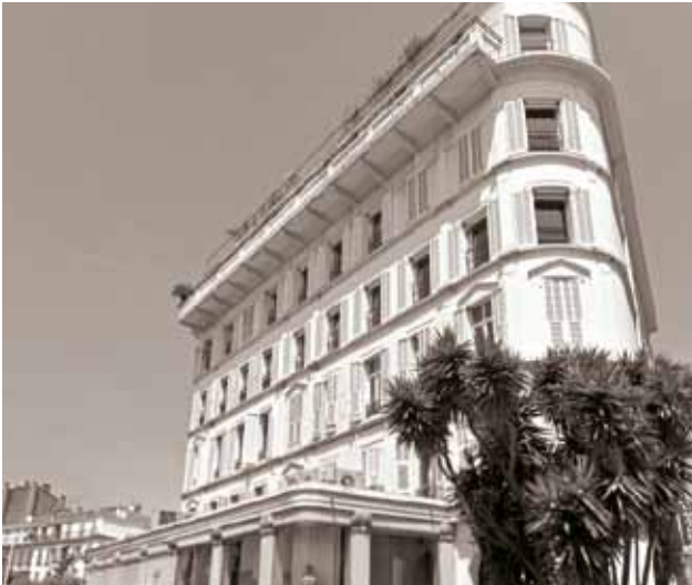
Cannes (F), Boulevard de la Croisette, 2 – Praga France S.à.r.l.
